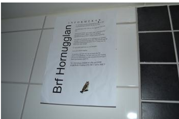
Test av frånluftsdon.
